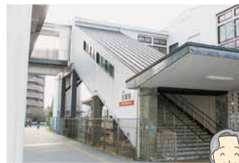
駅にエレベーター設置 南海高野線・白鷺駅
