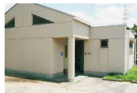
トイレ整備改修 金岡公園
