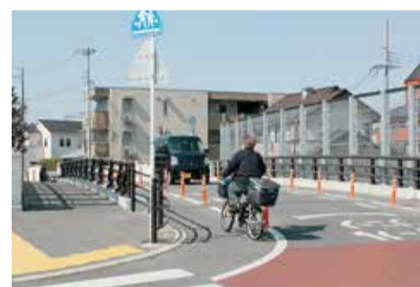
JRの歩道橋架け替え 阪和線第一今池橋
